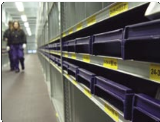
Plocklager på entresol, under uppbyggnad
