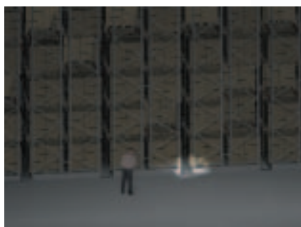
"Nattläge" för att förbättra luftcirkulation eller sprinklersystem.
